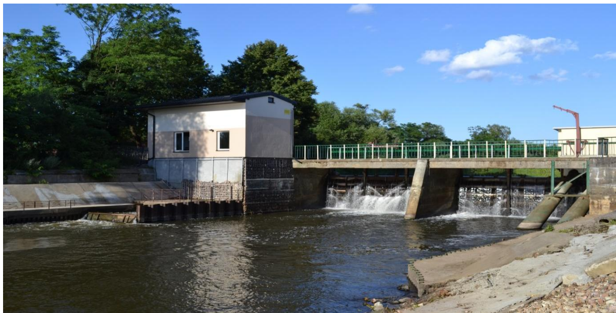
Zapora wodna w Kalinowcu.
