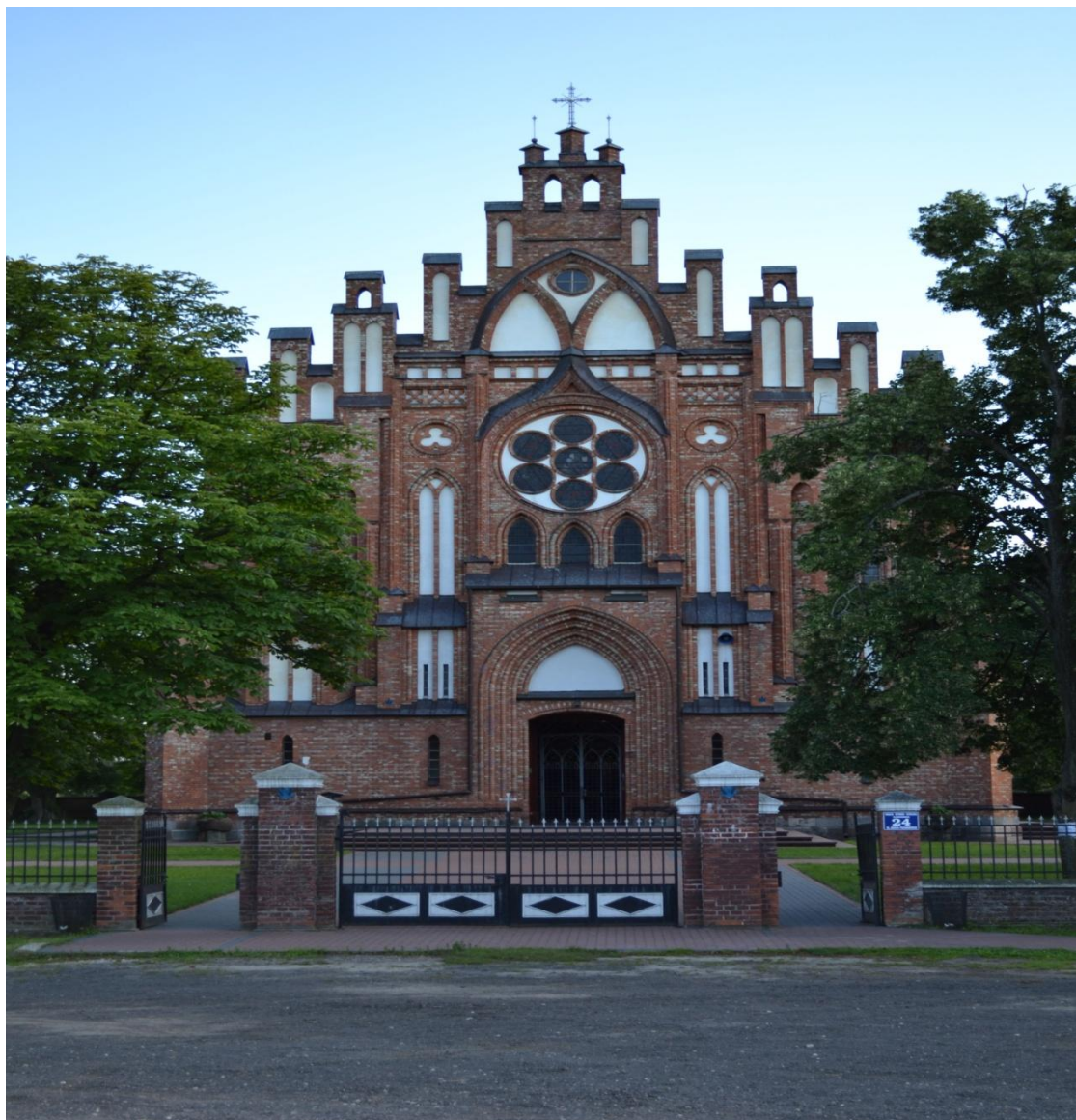
Kościół p.w. Niepokalanego Poczęcia Najświętszej Marii Panny w Kamionie. Fot Mariola Kielek
