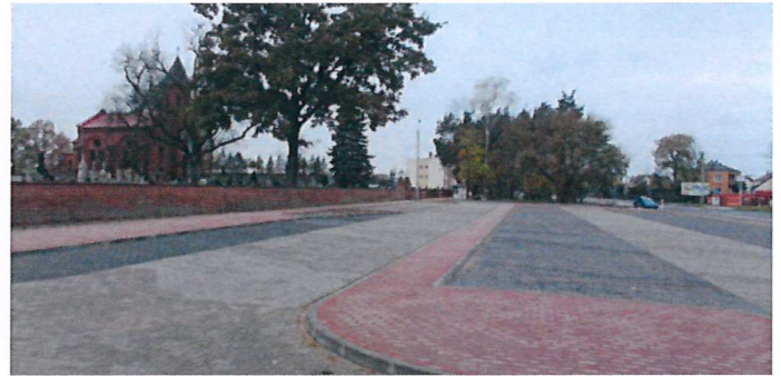
Budowa miejsc parkingowych ul. Kościuszki przy cmentarzu wraz z drogą wewnętrzną w Węgrowie
