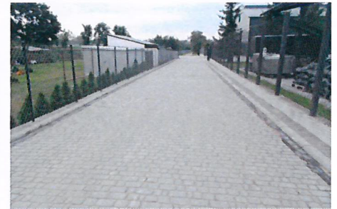
Przebudowa odcinka ulicy Prostej w Węgrowie
